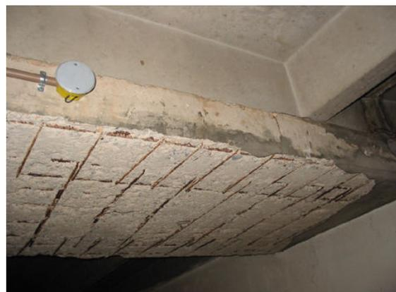
Foto N° 11 : corrosión por carbonatación acelerada por atmósfera contaminada
