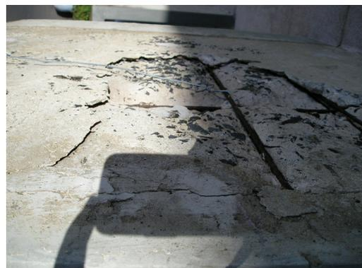
Foto N° 3 : corrosión en balcones de un edificio
