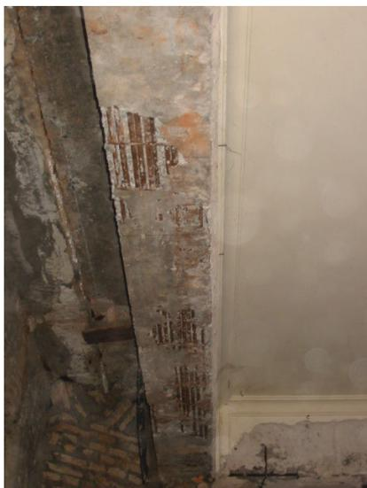
Foto N° 2: corrosión en vigas en una junta
