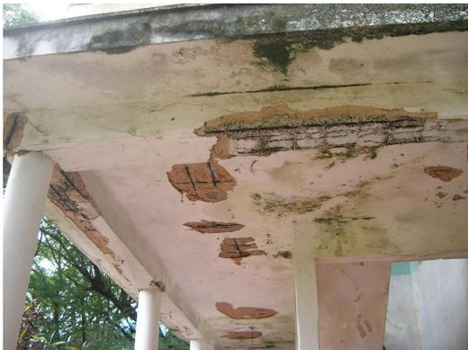
Foto N° 12 : corrosión por lixiviación
