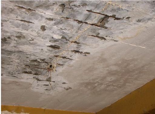
Foto N° 8 : corrosión en losas por lixiviación
