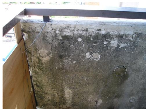
Foto N° 4: fisuras debidas a la corrosión de armaduras
