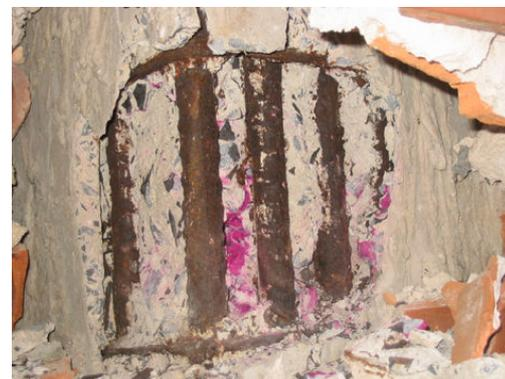
Fotos N° 9 y 10 : corrosión por cloruros y carbonatación
