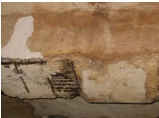
Foto N° 1: corrosión en vigas
