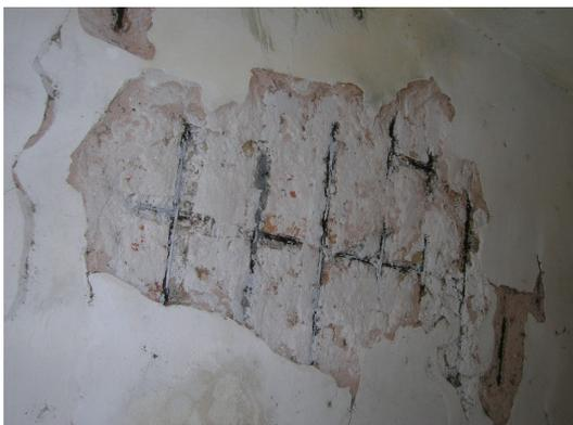
Foto N° 13 : corrosión por lixiviación y diseño defectuoso
