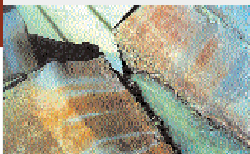
Desintegración de una canaleta de hormigón de una industria
